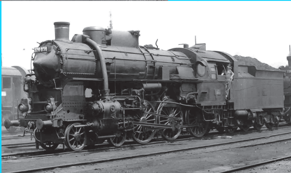
7. ábra 328,038 pályaszámú, gyorsvonati mozdony Debrecenben 1958. szeptember 24-én. A Helmut Griebl gyűjteményéből származó fotót Helmut Fröhlich készítette. A MÁV részére a sorozat egy részét, 58-at a MÁVAG, míg a másikat, szám szerint 100-at a kasseli Henschel-gyár szállította. Anyagi okok miatt 17-et a Csehszlovák Vasút vett át. A járművek engedélyezett sebessége 100 km/h volt.
