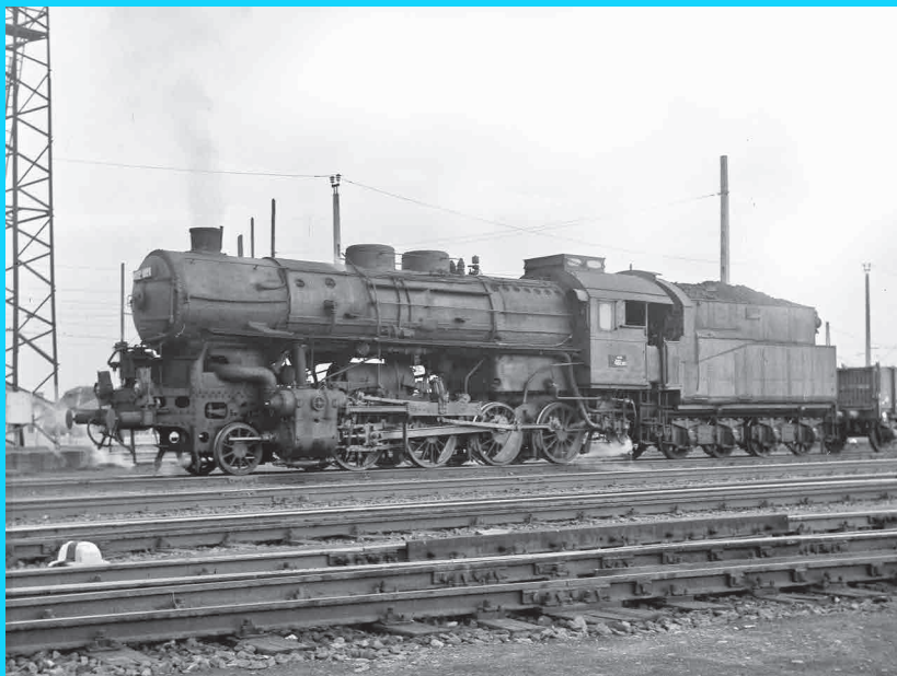
3. ábra 402,001 pályaszámú, 1'D-h2 tengelyelrendezésű, a 424-es üzemeltetési és fenntartási tapasztalatai alapján szerkesztett, kifejezetten tehervonati mozdonytípus. Két mozdony épült a sorozatból. Mohay László felvétele. Molnár Tibor József gyűjteményéből.
