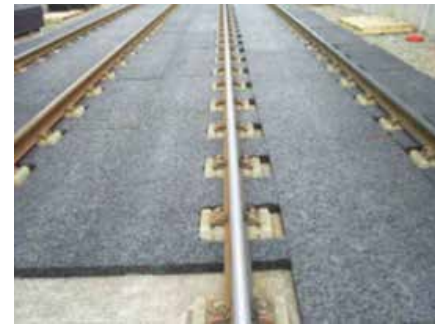
3. ábra: Városi vasút zajcsökkentő gumieleme [4]
