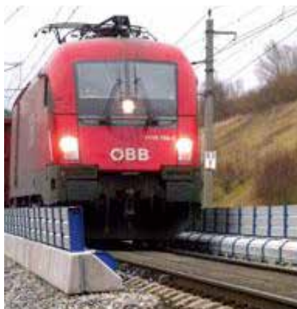
1. ábra: „SilentTrack” alacsony építésű zajvédő fal [1]
