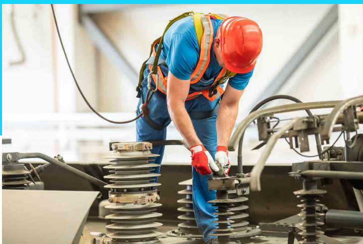
A főmegszakító beépítésének egyik mozzanata a Stadler Magyarország Vasúti Karbantartó Kft. pusztaszabolcsi telephelyén
